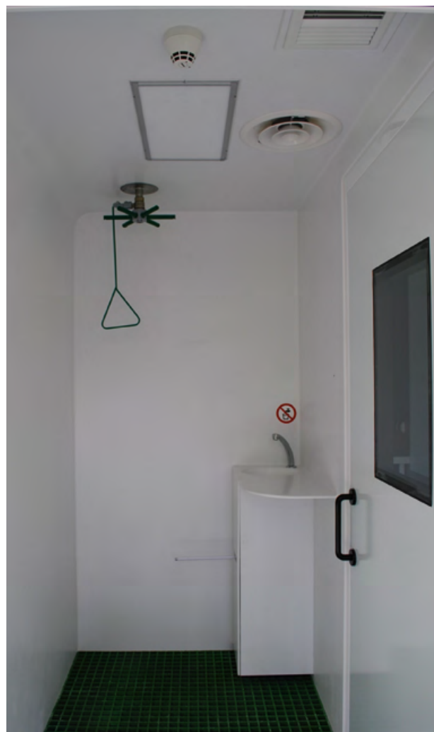
Cloison et douche de sécurité laboratoire P3
